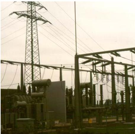
In Umspannwerken erfolgt die Transformation von der Höchstspannungsebene des überregionalen Stromverbundes auf die Mittelspannung für die regionale Verteilung elektrischer Energie.
