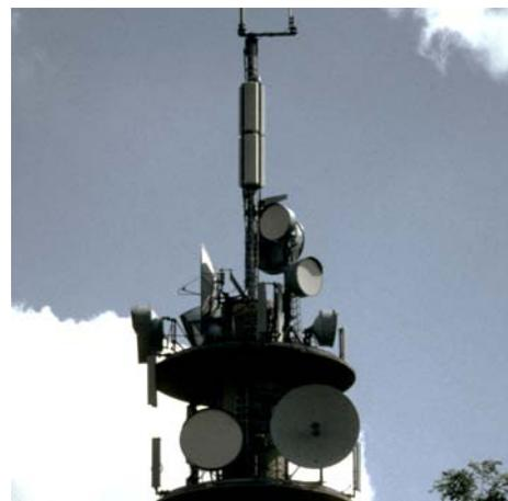
Parabolantennen sorgen für eine starke Bündelung der Abstrahlung von Richtfunkanlagen. Außerhalb des Hauptstrahls von Richtfunkstrecken ist die Intensität der Strahlung daher in der Regel sehr gering.
