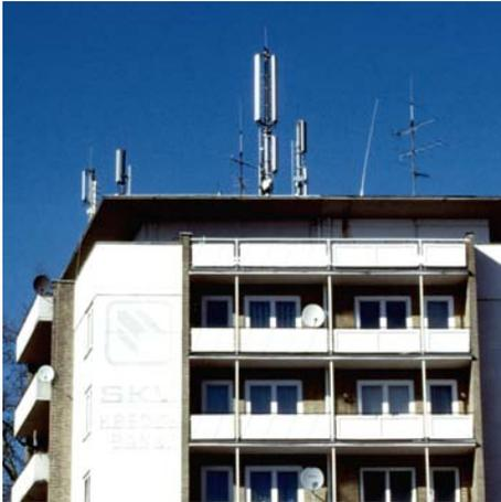
Mobilfunkanlagen stellen bezogen auf die Fläche die Hauptquelle hochfrequenter elektromagnetischer Felder dar.
